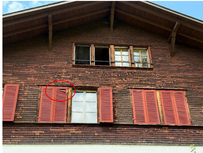
Fassadenansicht mit defektem Fensterladen
