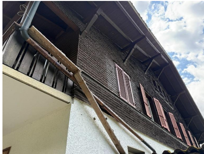
Dachwasserfallrohr an Fassade
