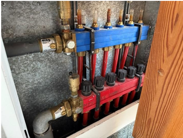
Verteiler Fussbodenheizung DG
