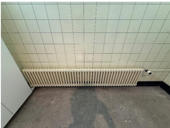
Bild 11 – ehemaliger Duschraum UG, Fliesenkleber vermutlich asbesthaltig
