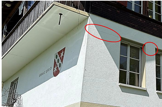
Fassade mit markierten Rissen
